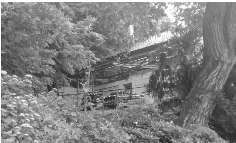
L'ultima fotografia scattata al grotto il 6 giugno 2016, giorno della demolizione
