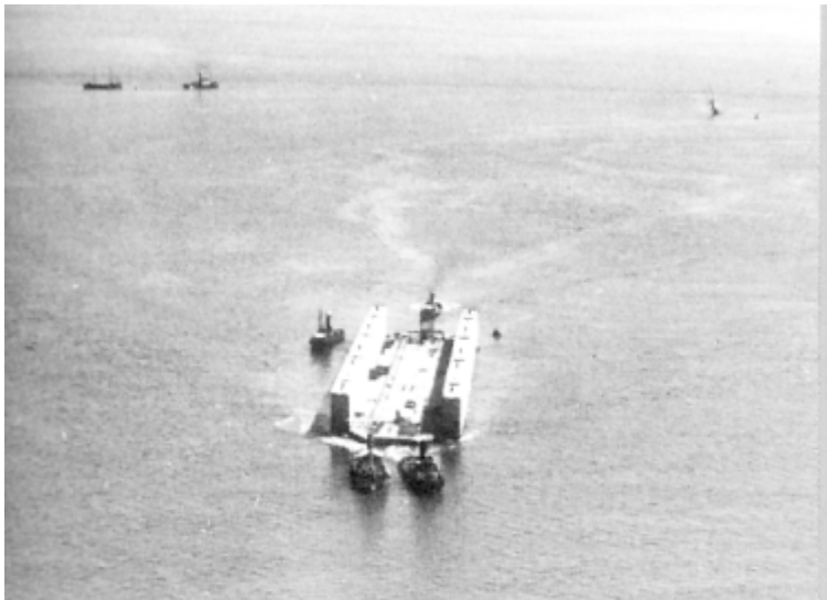
Completamento strutture funzionanti a galla. Da "100 anni di ingegneria costruendo l'Uruguay".
